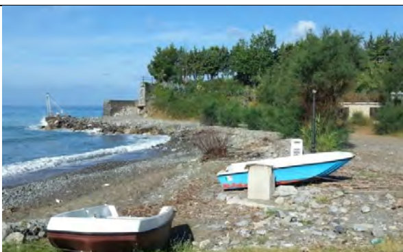
vista nord della struttura – scogliera aderente, punto attracco
