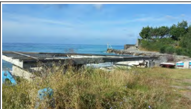
attrezzature di alaggio e pontile di attracco mobili
