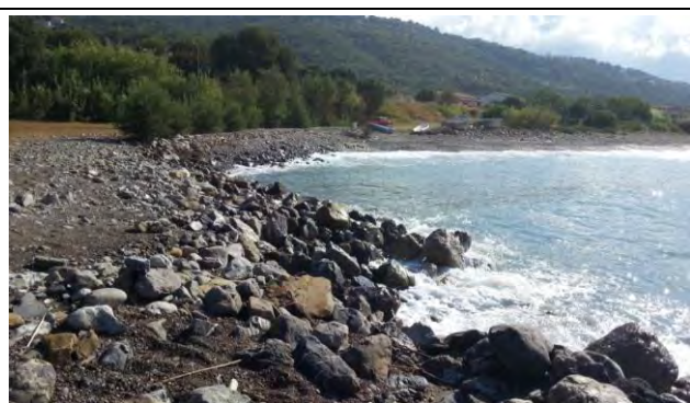
vista sud - scogliera aderente di protezione con gli elementi rimossi
